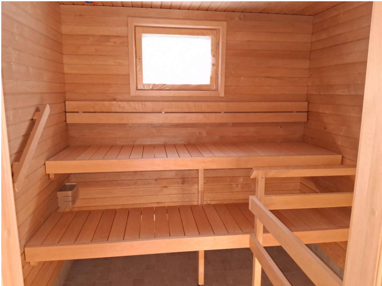
Yhteisrakennuksen saunatilat valmistuvat parhaillaan
