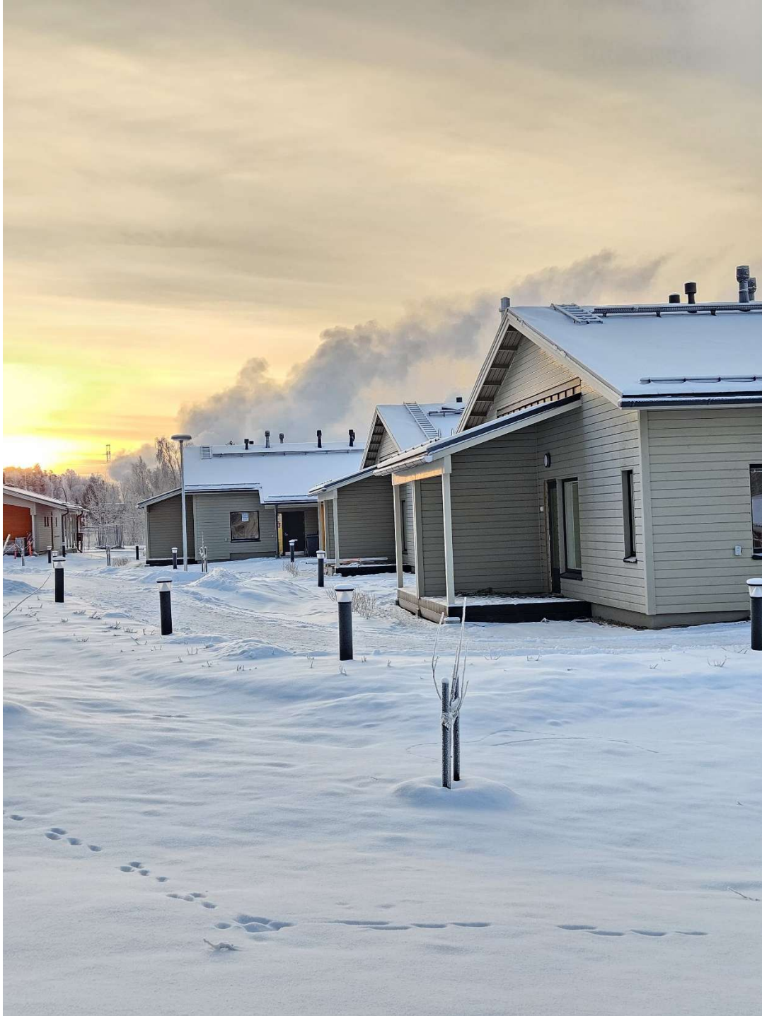
Yleiskuva työmaasta (etupiha). Terasseille asennetaan vielä myöhemmin kaiteet.
