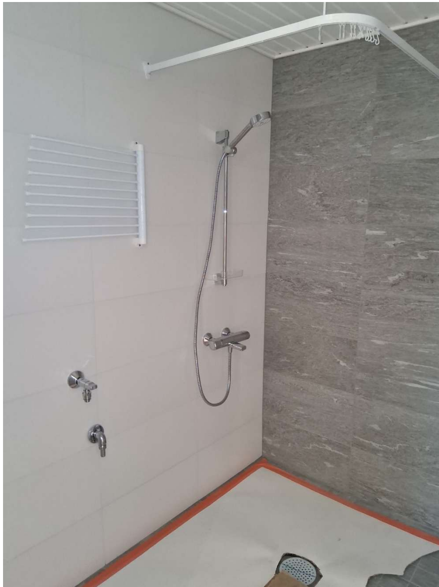
Kylpyhuoneiden varusteet ovat paikoillaan
