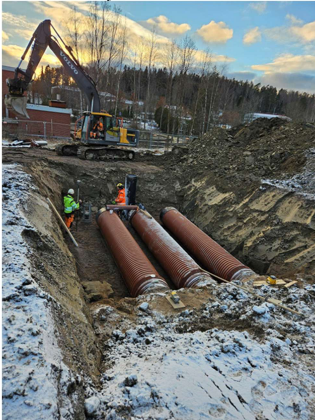
Hulevesien viivytyskenttä tehtiin marraskuussa
