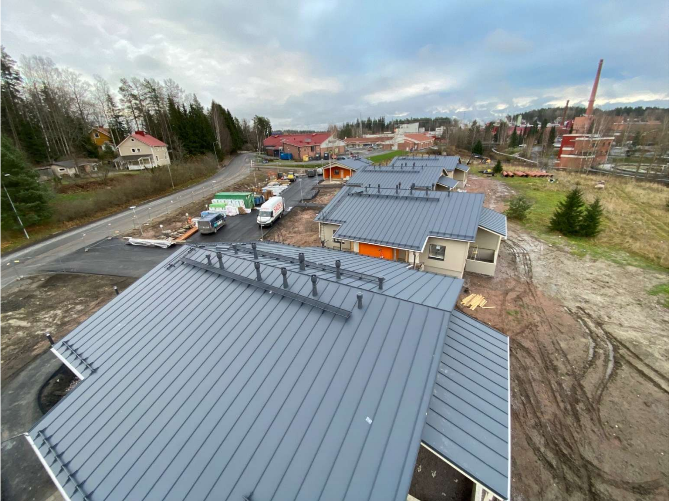
Yleiskuva työmaasta nostimen korista katsottuna (etualalla D-talo)
