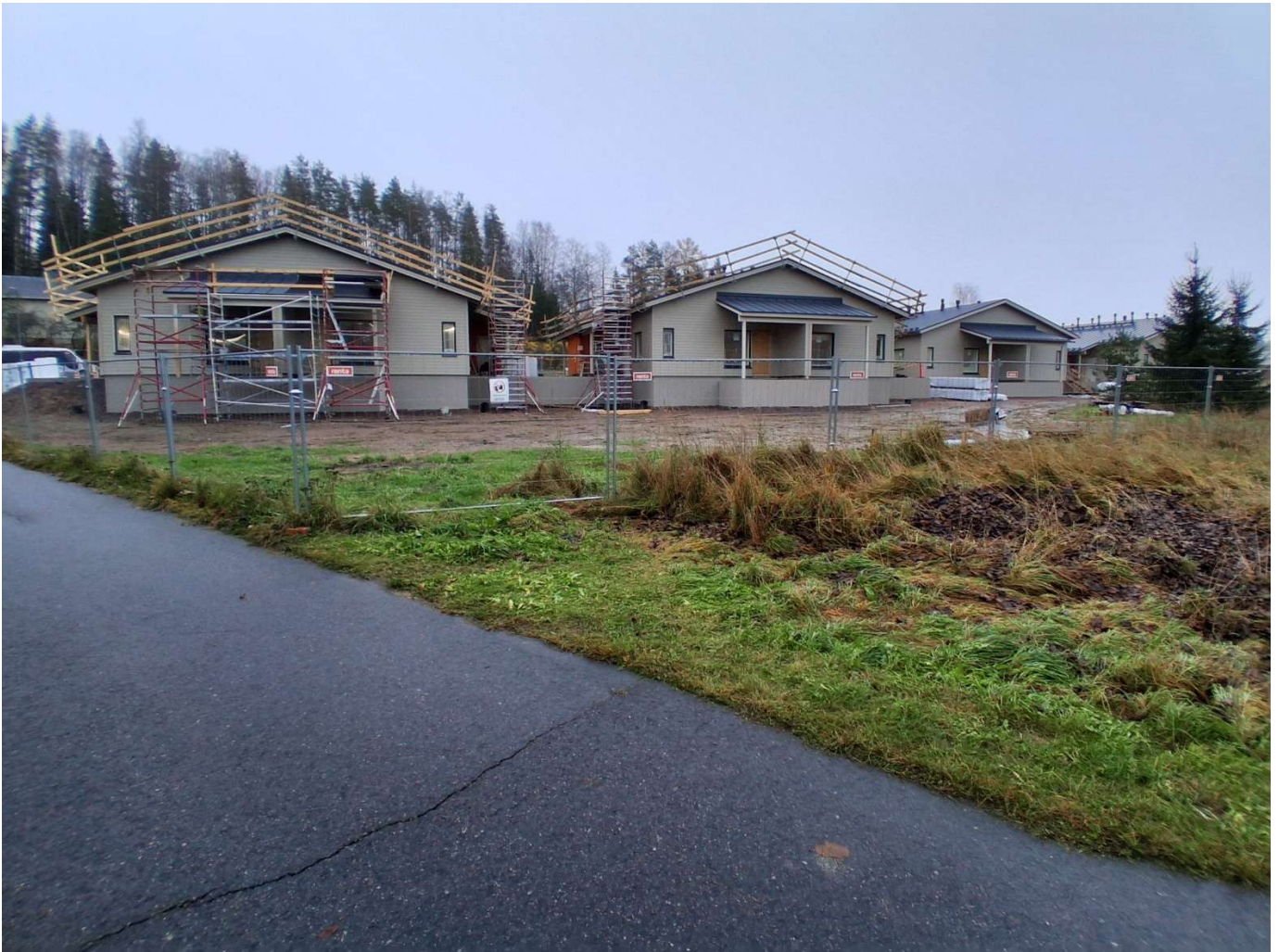
Yleiskuva työmaasta joelta katsottuna 29.10.2025
