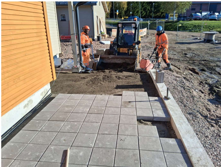
Pihakivien asennus aloitettiin A-talon päädystä
