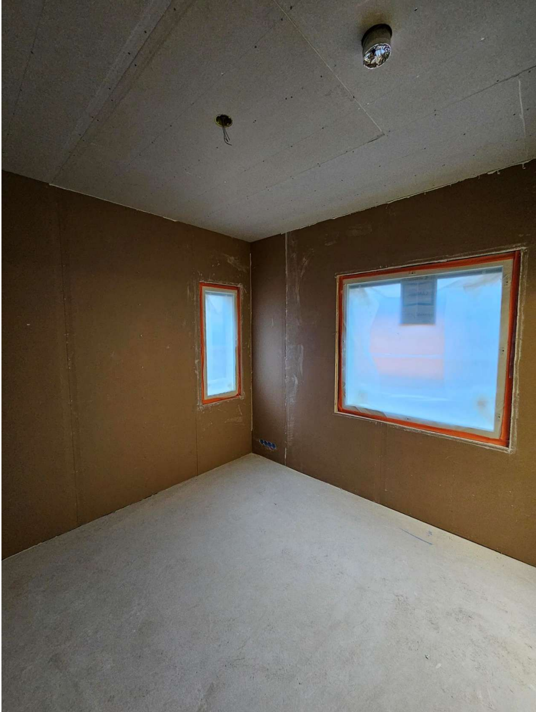
C-talon kipsilevypinnat valmistuivat viikolla 44 (asunto 9/makuuhuone)
