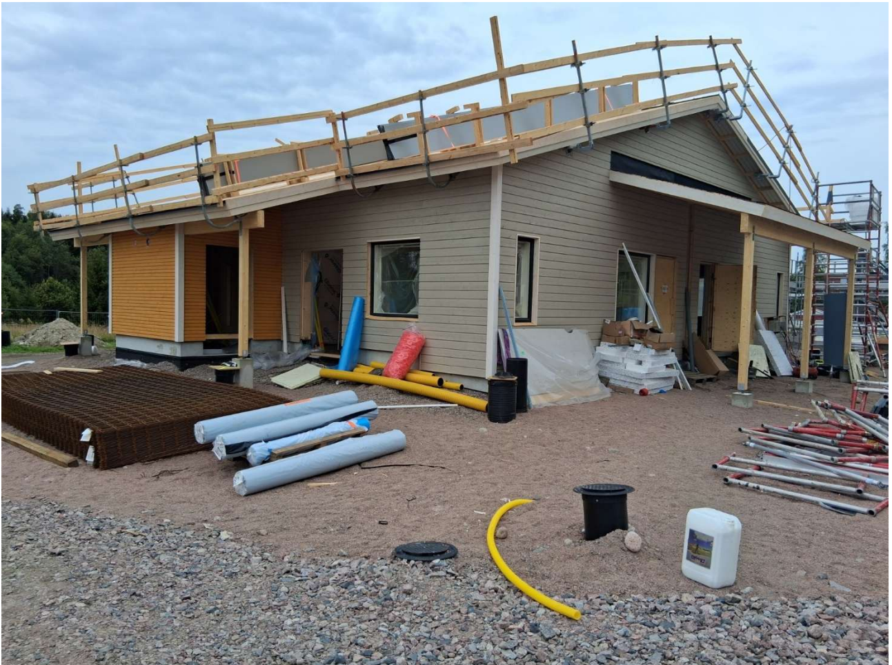
A-talon runko on pystytetty ja vesikattotyö on käynnissä.
