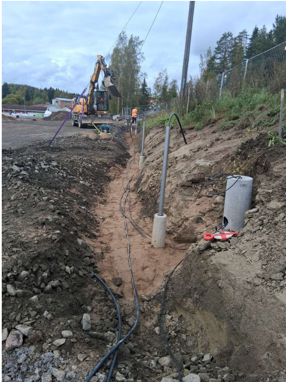
Pysäköintialueen lämmitys- ja valaisintolppien asennus käynnissä
