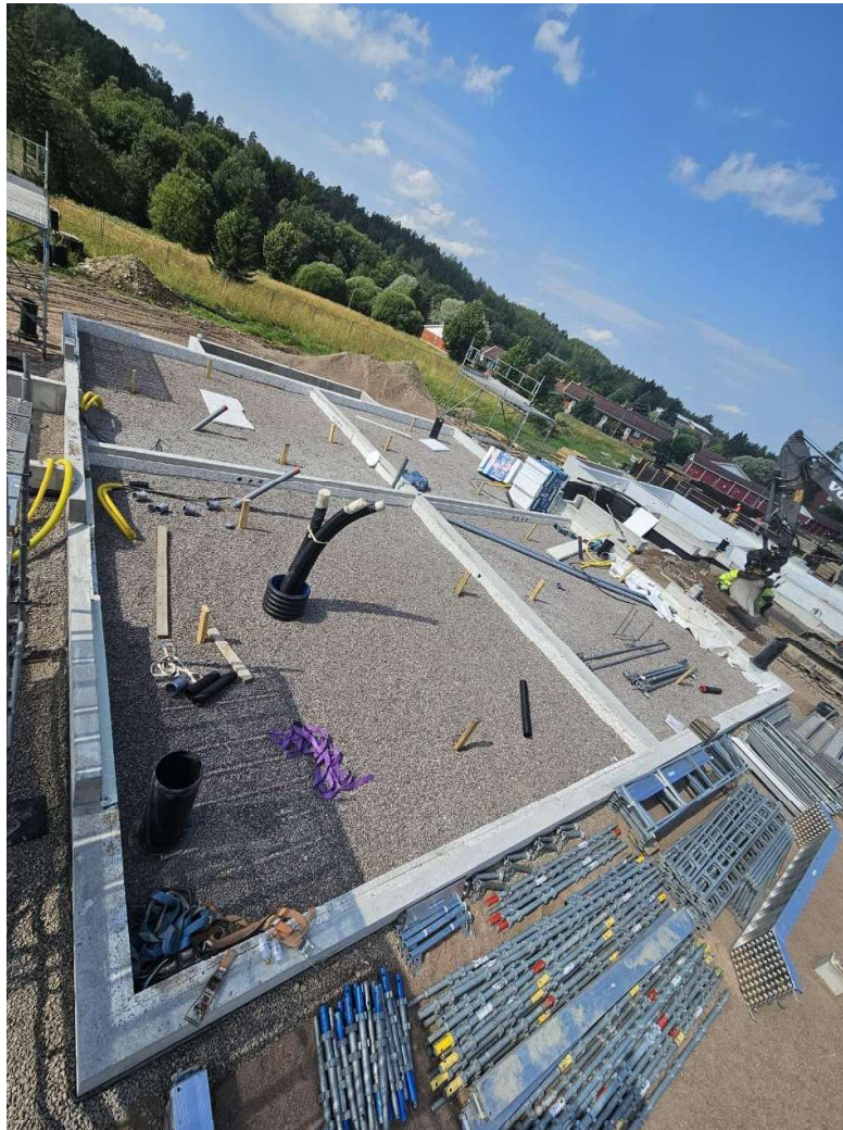
A-talon perustukset ja täytöt valmiina. Runkoasennus voi alkaa.
